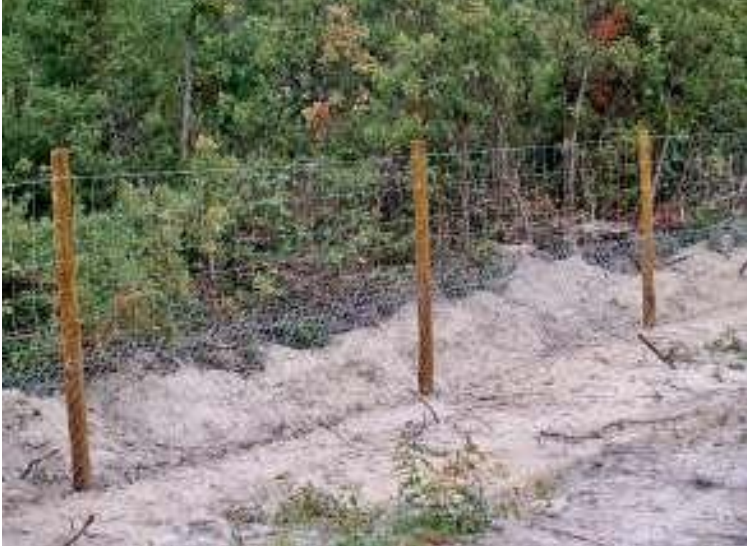
Construcción de cercados
